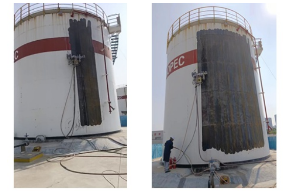
开始除锈作业30分钟后除去面积 开始除锈作业60分钟后除去面积
